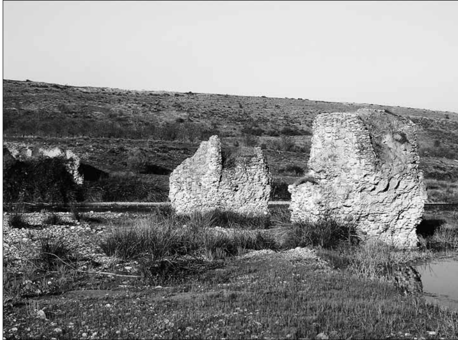
Fig. 48. Agoncillo. Ruinas del puente construido sobre el río Leza a fines del siglo XVIII.
