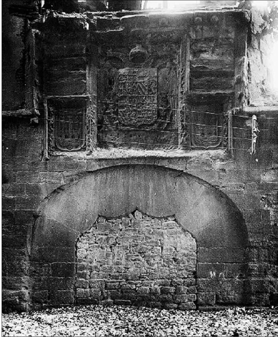
Fig. 1. Puerta del Revellín. (Archivo fotográfico del I.E.R., nº 833).
