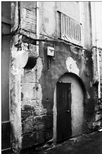
Fig. 58. Logroño. Ménsula para apoyar el vuelo de los pisos superiores, en la calle del Hospital Viejo, nº 6.
